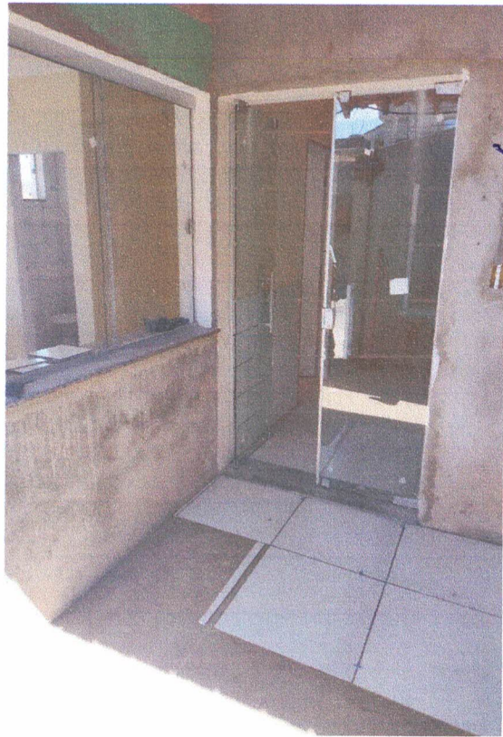
PISO CIMENTADO COM ASSENTAMENTO PISO CERÂMICO
