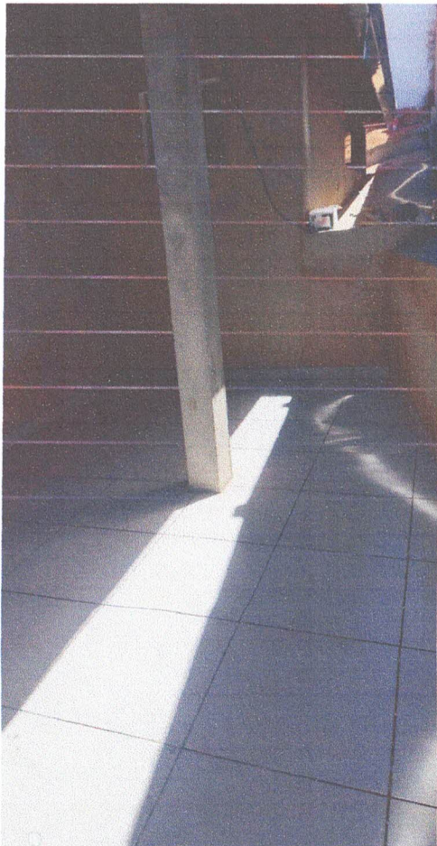
PISO CIMENTADO COM ASSENTAMENTO PISO CERÂMICO
