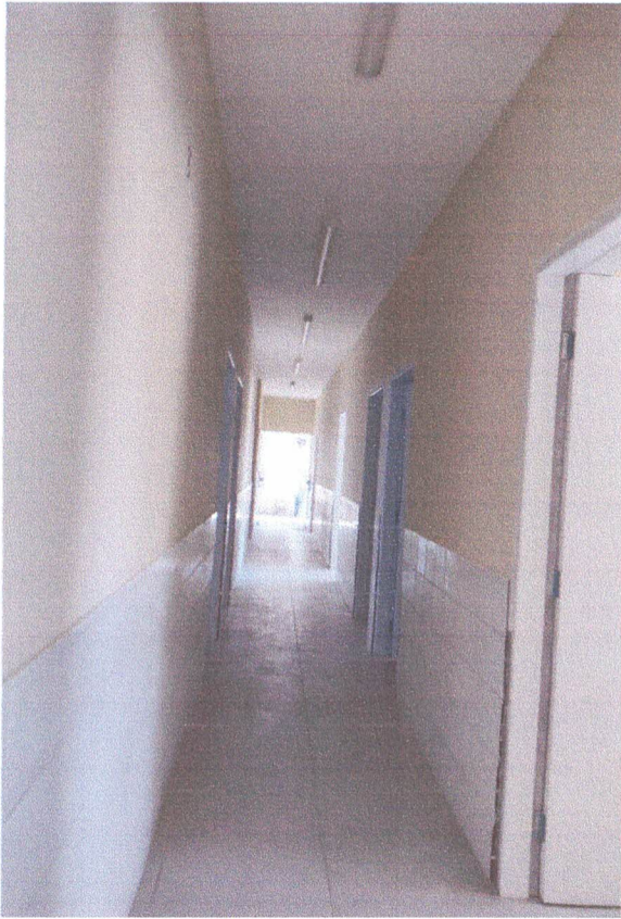
ILUMINAÇÃO EM GERAL / PINTURA PAREDES E PORTAS
