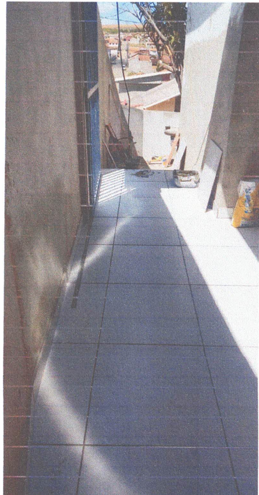
PISO CIMENTADO COM ASSENTAMENTO PISO CERÂMICO
