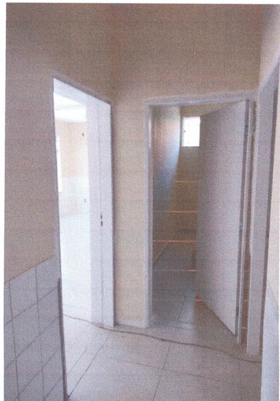
ILUMINAÇÃO EM GERAL / PINTURA PAREDES E PORTAS
