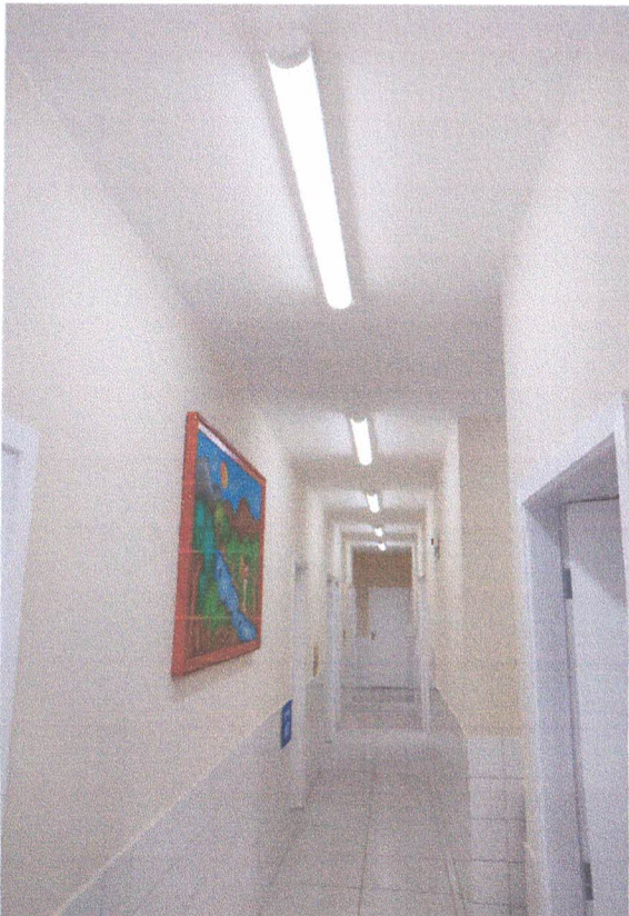
ILUMINAÇÃO EM GERAL / PINTURA PAREDES E PORTAS
